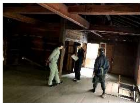
改修中の空き家を検分するメンバー
