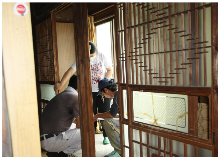
空き家の内部を調査する様子
