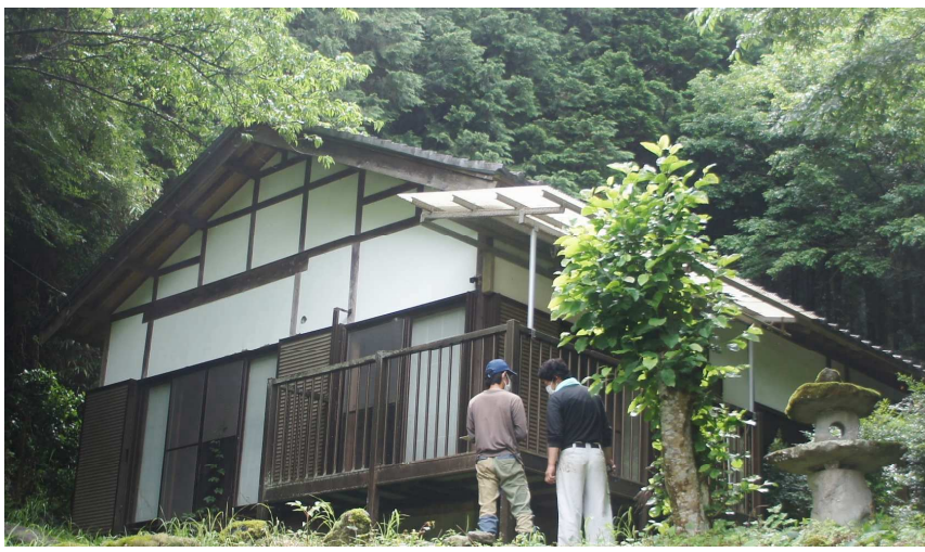
メンバーと確認しながら調査を進めていきます
