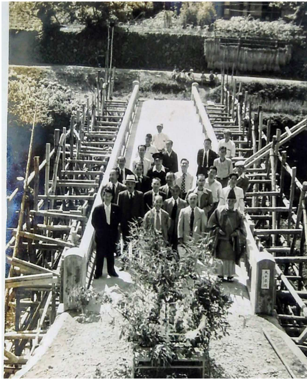
竣工当時の大千原橋 (昭和28年撮影)
